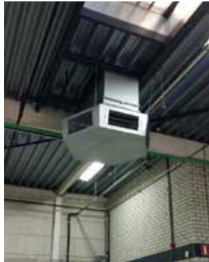
6-zijdige hexagonale uitblaaskap voorzien van horizontale schoepen
